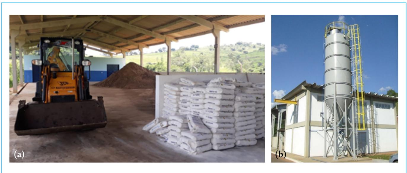
Figura 2 – Armazenamento da cal virgem: (a) para ETEs de pequeno porte, em sacos de 20 kg; (b) para ETEs de grande e médio porte são empregados silos.
